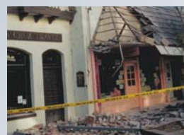
Las empresas y los apartamentos de viviendas pueden sufrir serios daños. (Foto USGS)
